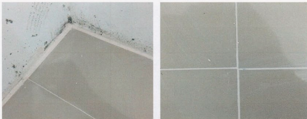
Figura 3 – Instalação - juntas: (a) cantos da câmara, (b) entre pisos
