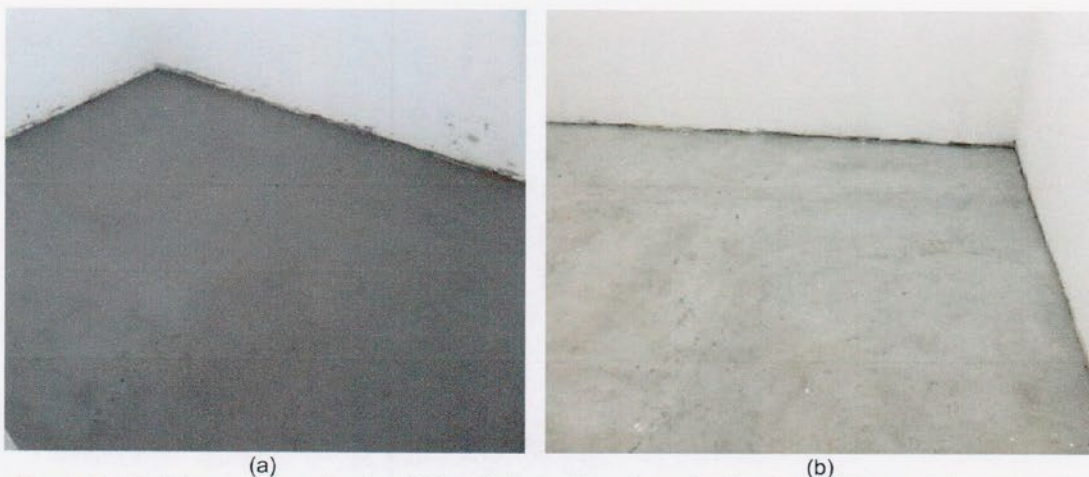
Figura 1 – Moldagem do contrapiso (a) imediatamente após o término da moldagem, (b) aos 28 dias de cura
