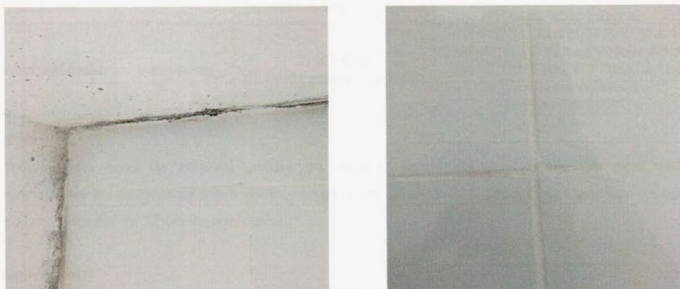
Figura 3 – Instalação - juntas: (a) cantos da câmara, (b) entre pisos
