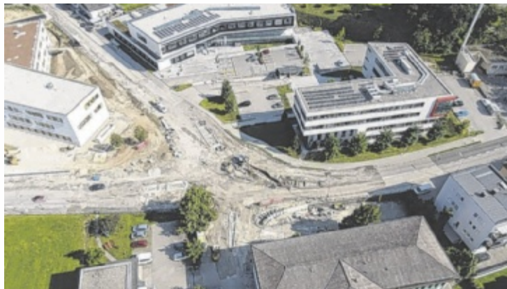
Der Kreisverkehr beim neuen Bildungscampus wird derzeit gebaut. Foto: HIPI ZT GmbH
