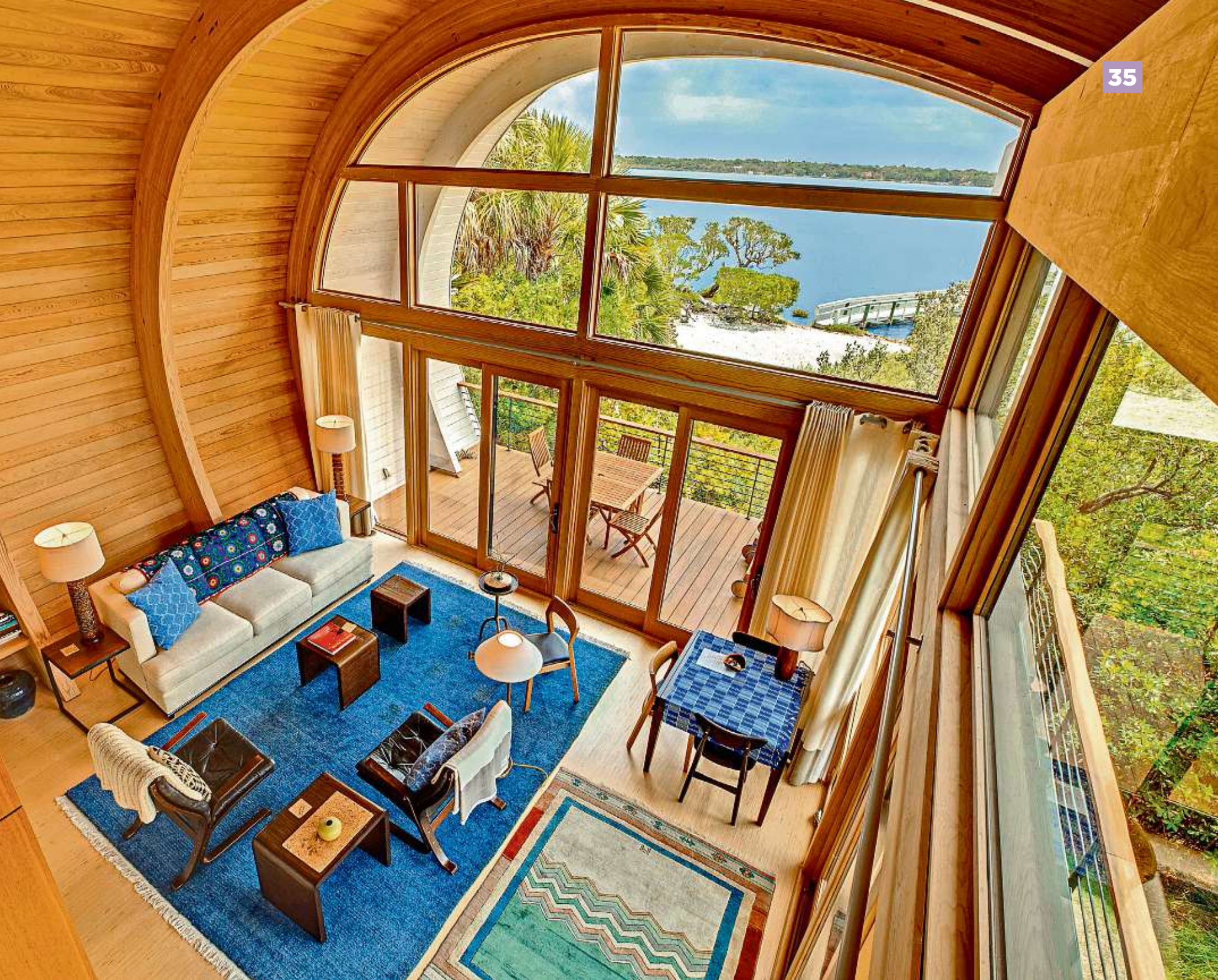
La estructura del muro que se convierte en techo se hizo con vigas de pino.
