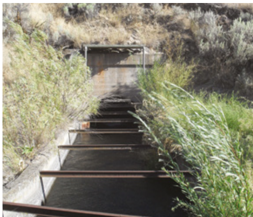
Надземный деревянный лоток
