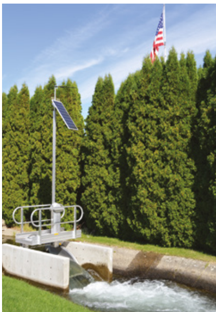
Реакция каждого затвора «FlumeGate» учитывает индивидуальные особенности канала, работу которого она регулирует
