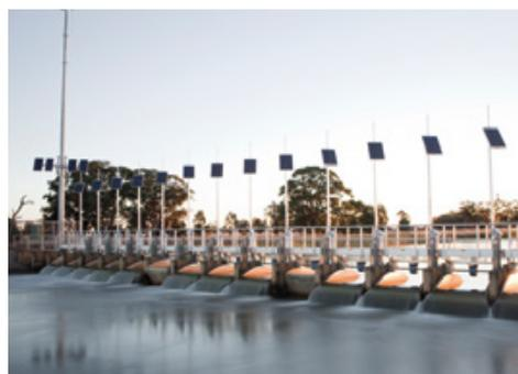
Узел радиосвязи и затворы «FlumeGate», регулирующие работу канала «East Goulburn Main»
