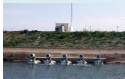
Il software NeuroFlo controlla la portata delle pompe ed aziona i FlumeGates per mantenere livelli stabili di acqua a valle
