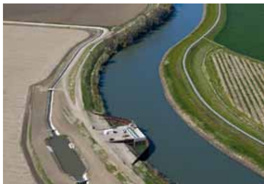
Vista aerea che mostra la nuova stazione di pompaggio dell'acqua che preleva dal fiume Sacramento e scarica nel bacino di raccolta, il quale a sua volta alimenta i canali nord e sud
