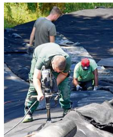
Arbeiter verbinden Dichtungsbahnen, damit kein Wasser versickert.
