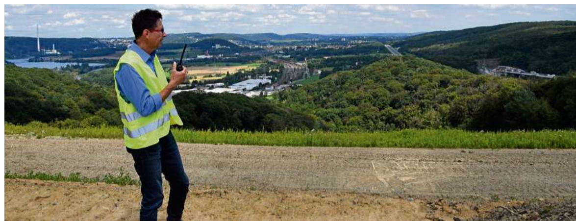
Schöner Blick ins Ruhrtal oder zur A1-Baustelle an der Talbrücke Volmarstein (rechts): Projektleiter Rainer Opitz funkt am Rand eines fast fertig gestalteten Abschnitts, wo eines Tages eine Photovoltaikanlage stehen könnte.
