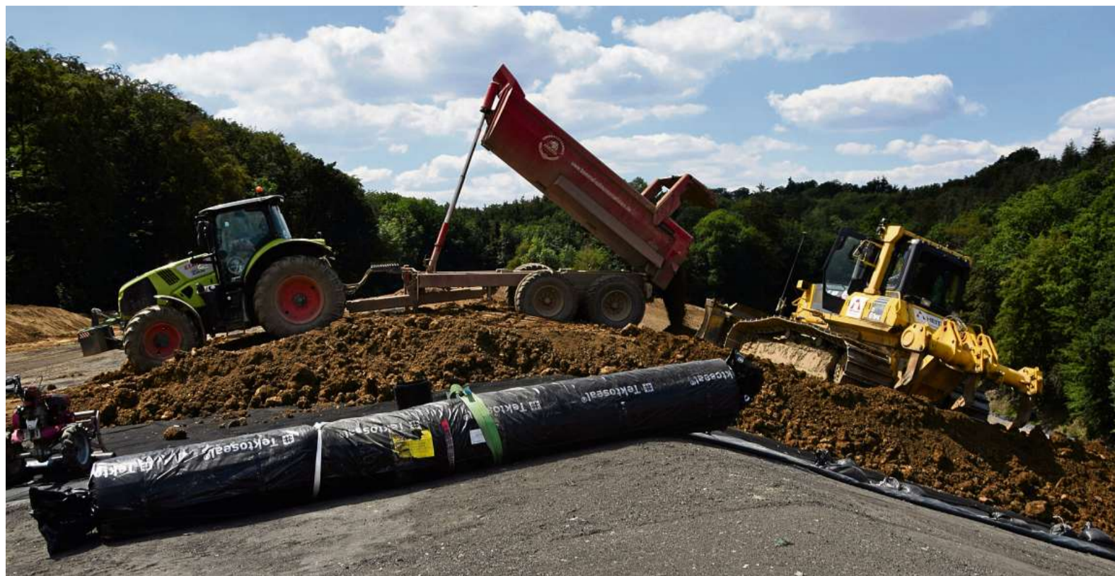
Arbeiten zur Rekultivierung: Zahlreiche Lkw liefern täglich viel Material zur Deponie Enerke nach Volmarstein, wo die Projektentwicklungsgesellschaft direkt neben der A1 die ehemaligen Flächen von der Firma Brühne und vom Ruhrverband abdichten lässt.
