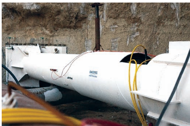
Fig. 4: Încărcare de probă pe unul dintre șpraițurile instalate
