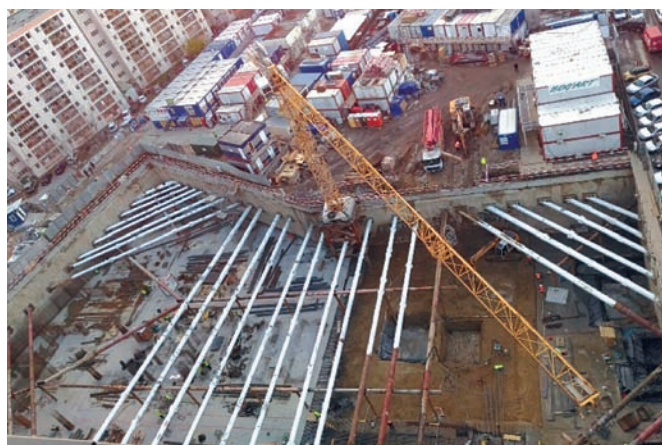
Fig. 5: Excavație adâncă în perioada execuției
