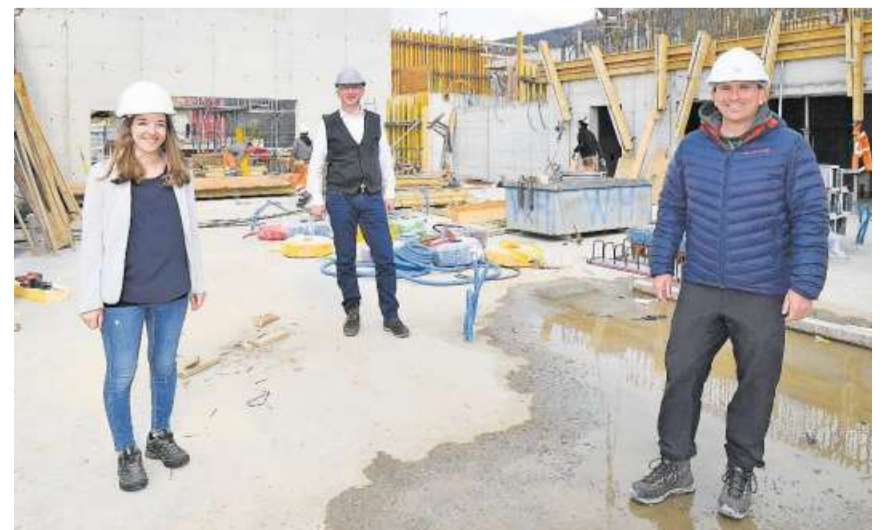
Sie führten über die Baustelle: Ramona Häfeli (Kommunikationsverantwortliche GAG), Patrick Scarpelli (Projektleiter) und André Grolimund (GAG-Verwaltungsrat).
