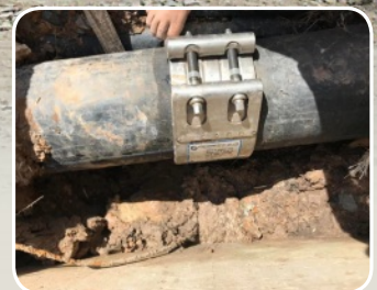
▲ PE Pipe Repair
