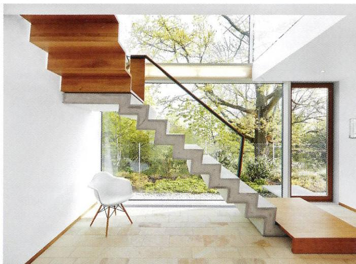
48.1: Ein in Beton gefalteter Treppenlauf nutzt die Raumbreite. Die restliche Höhe wird – um 90 Grad gedreht – mit gefaltetem Holz überwunden. (Arch.: Volker Schwab)
