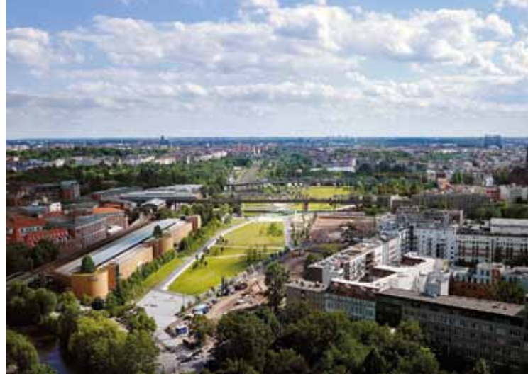
Das Gebäude (zu sehen in der Mitte am rechten Bildrand in der Verlängerung der denkmalgeschützten Hochbahntrasse) liegt direkt am rd. 26 ha großen, 2013 fertiggestellten Park am Gleisdreieck
