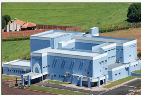
Hospital de Câncer de Barretos – Unidade de Jales.
