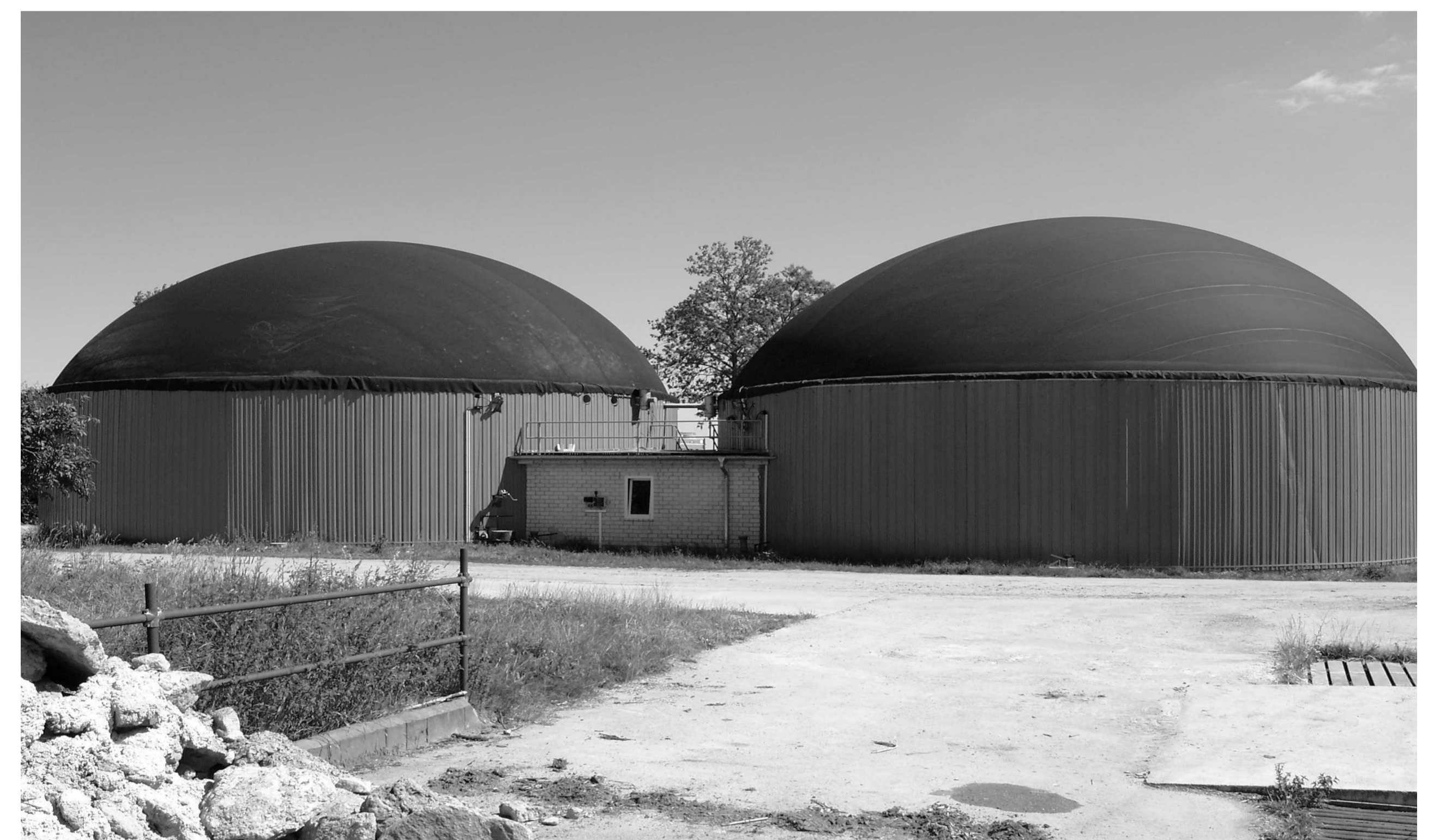
Biogasanlage zur Monofermentation von Energiepflanzen; Reaktor (links) und Nachgärer (rechts)
