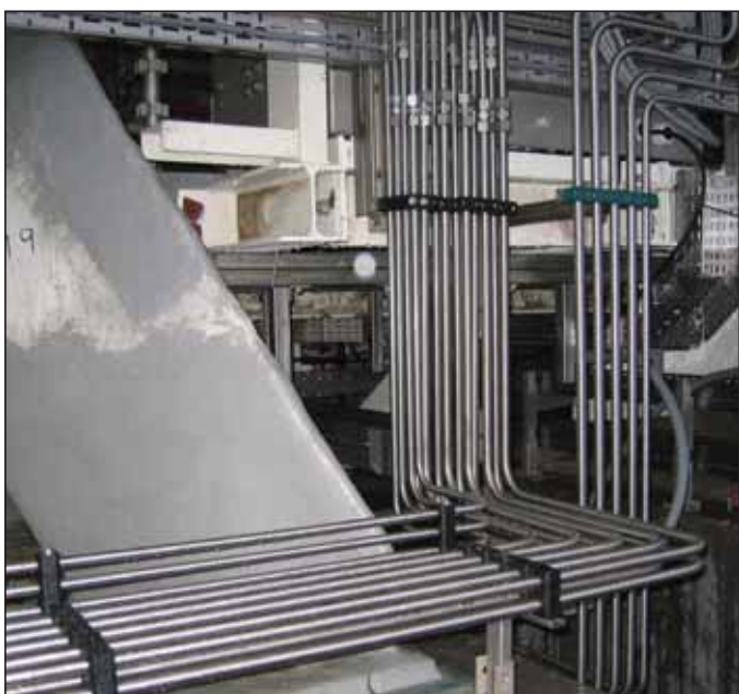
Rørlegging gjort av fagarbeidere.
