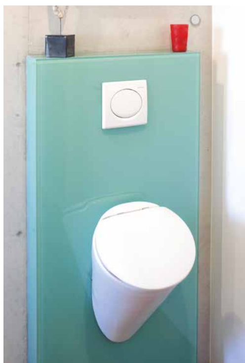
WANDVERGLASUNG VON VORSATZ- SPÜLKASTEN AUS FARBIGEM GLAS
