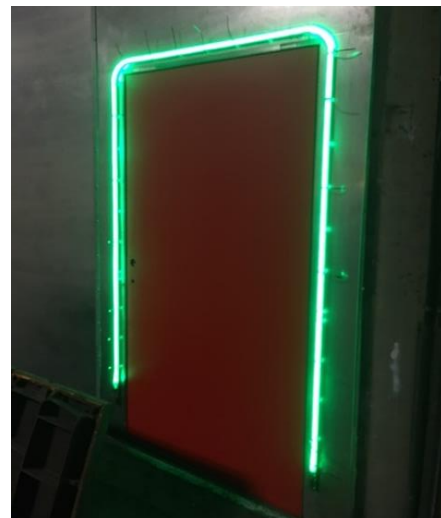
Bilde fra Tromsøysund. 30 stk nødutganger – montert 2016
