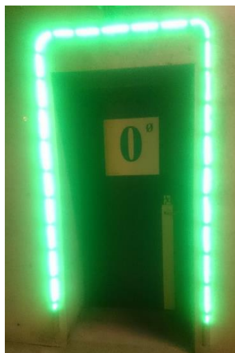
Grillstad tunnelen ble montert tidlig i 2015.
