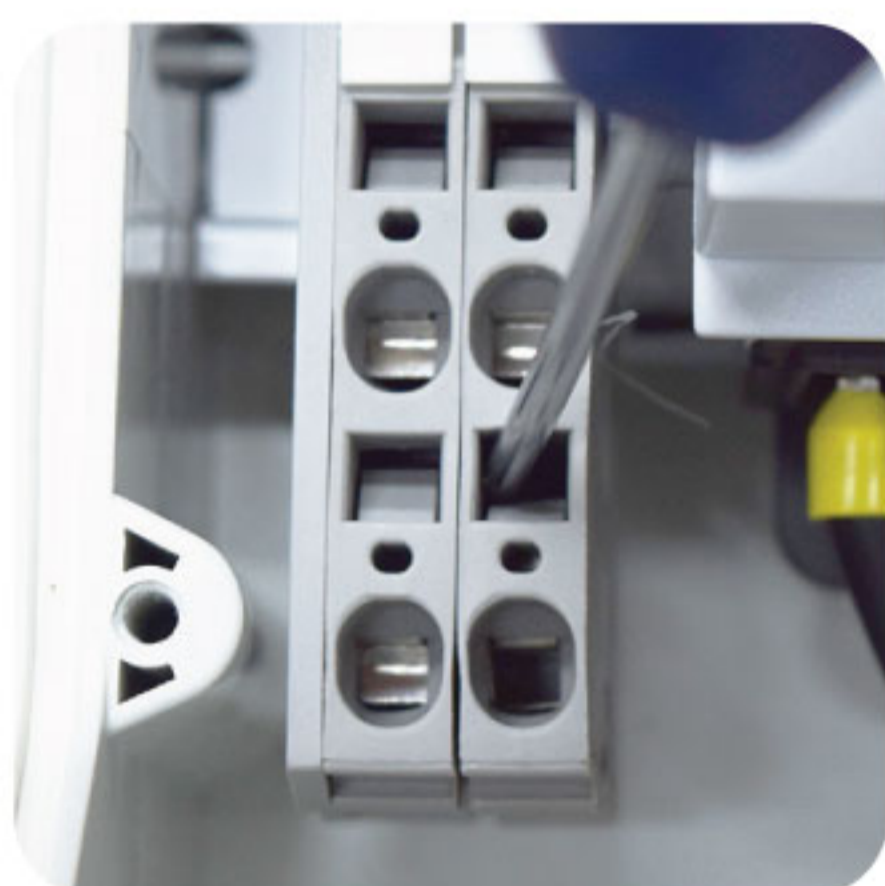
1 - Abra a mola do Borne com uma Chave de Fenda.
